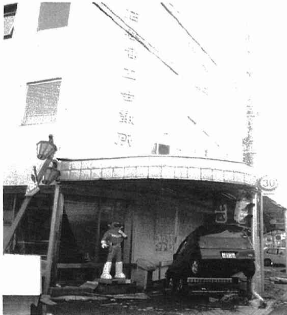
被害を受けた石巻商工会議所
